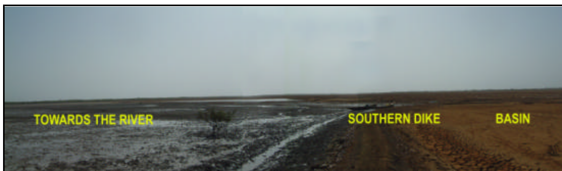
Figure 6 : Digue dans la partie sud de Bandial.
