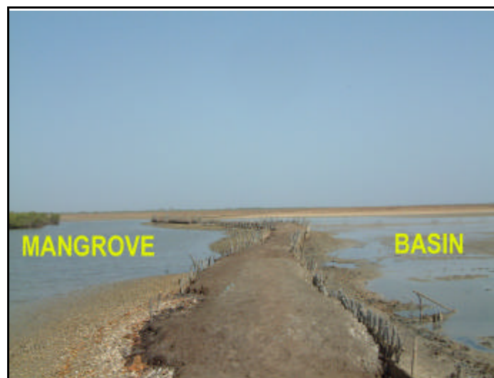
Figure 5 : Digue dans la partie nord de Bandial.
