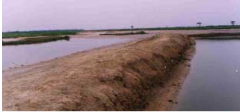
Figure 4 : Le bassin de M'lomp (à droite) avec une digue massive et haute.
