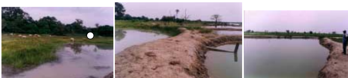
Figure 5 a, b, c : Thionck-Essyl - versant, nouvelle entrée d'eau douce, bassin
